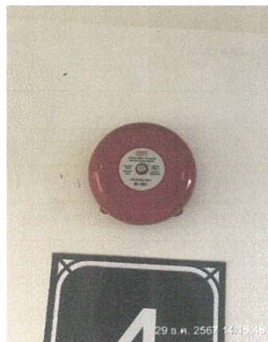
อุปกรณ์ส่งสัญญาณหนีไฟแบบกริ่ง
