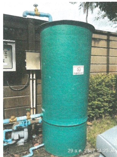
รูปภาพที่ 2.28 ถังกำจัด Aerosol และมีเทน
