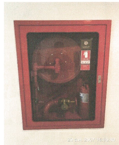
ตู้สายฉีดน้ำดับเพลิง (FHC)
